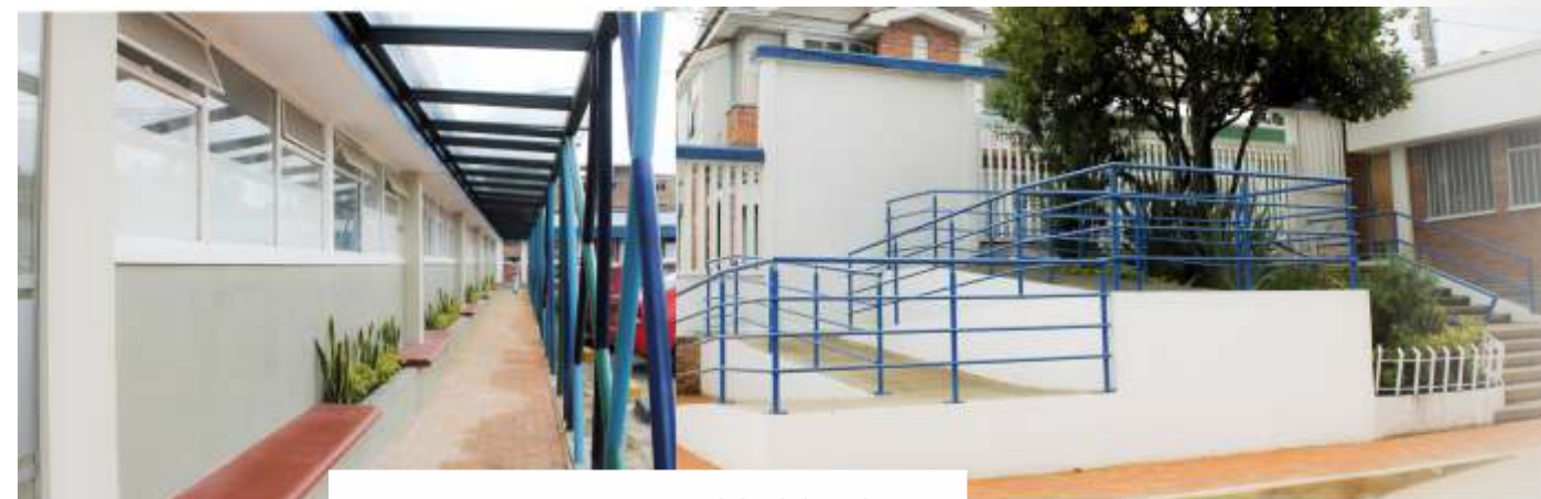
HALL Y RAMPA DE ACCESO HOY
